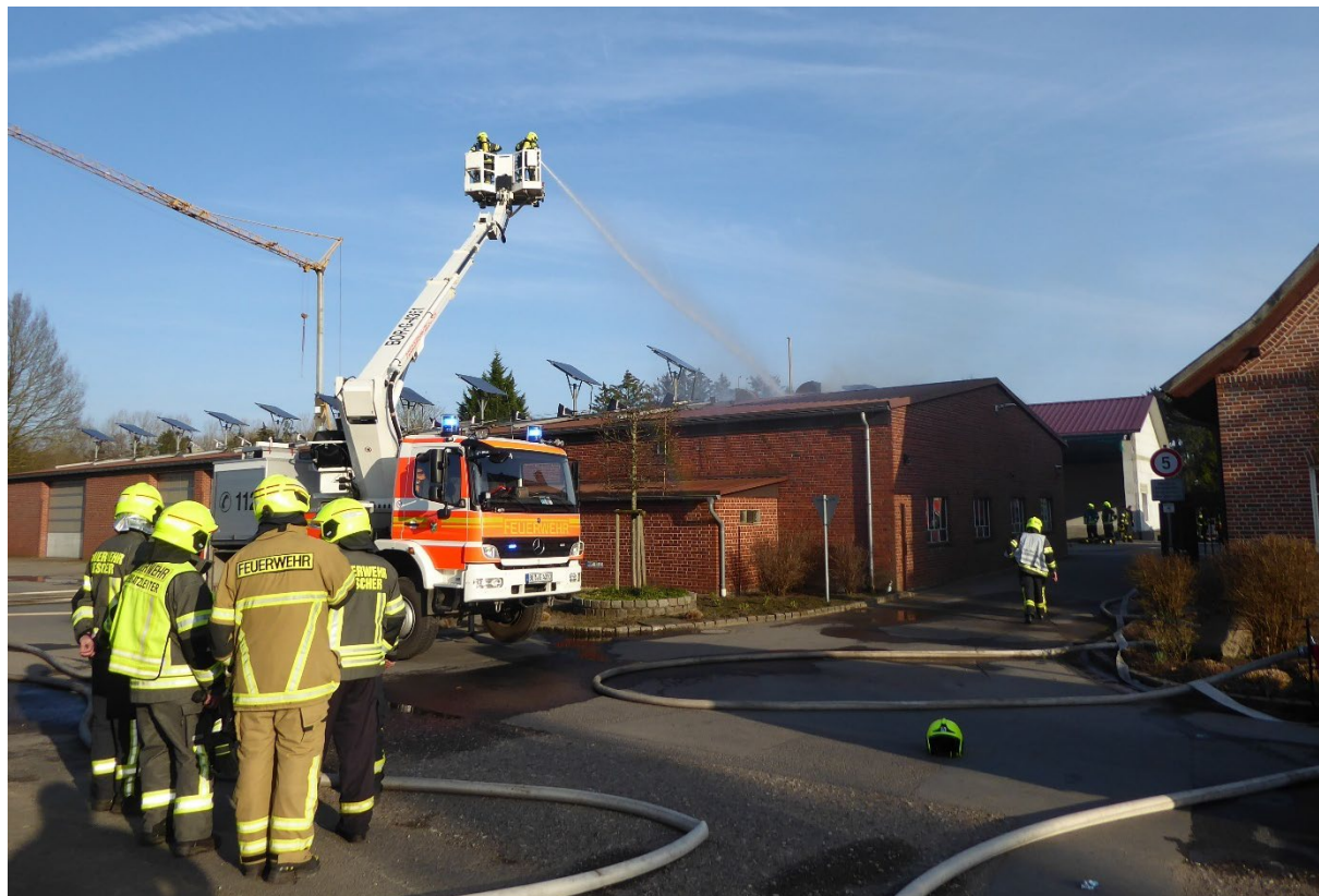
Ein Polizeihubschrauber bemerkte einen Brand in einer Halle eines Bauunternehmens im Ortsteil Hochmoor am 08.03.2025 und alarmierte die Feuerwehr. Dort brannte es im Dachbereich sowie im inneren der Halle. Aufwendige Löschmaßnahmen, unter anderem auch mit Schaummittel, führten schließlich zum Erfolg und der Brand konnte im vorgefundenen Ausmaß gehalten werden.
